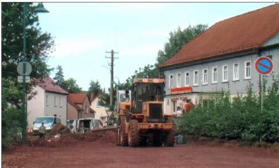
Straßenbauarbeiten in Schnepfenthal. Foto: H. Prasse
